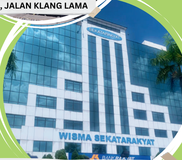
BANGUNAN PEJABAT, WISMA SEKATARAKYAT, GLOMAC BUSINESS CENTRE, KELANA JAYA
